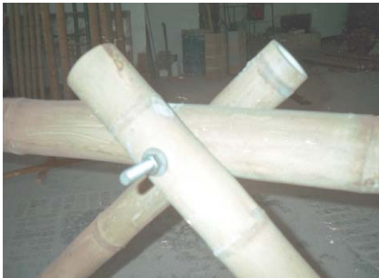
Foto No. 5. Unión de las diagonales con cordón superior (tomado de la referencia No 2)
