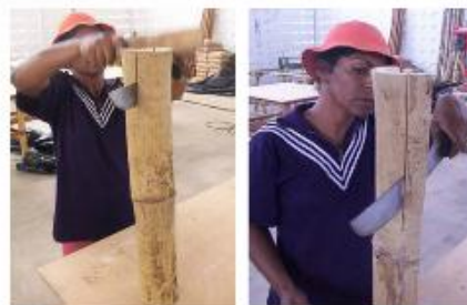
Figs 57 e 58 – Abrindo em meias-canais e cortando as ripas
