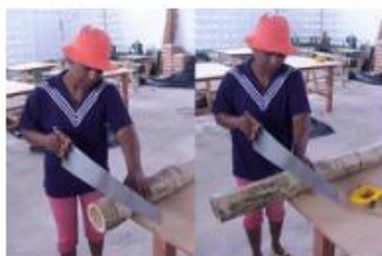
Figs 49 e 50 – Corte de entrenó com serrote
