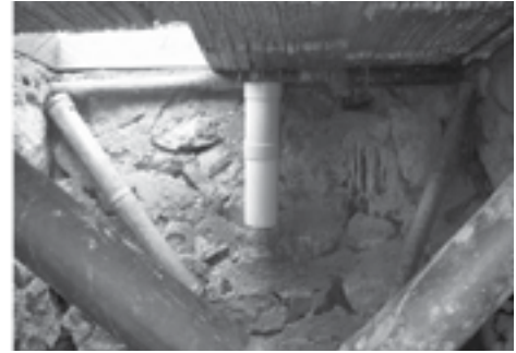
Pozo séptico en construcción
