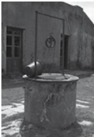
Aljibe para extracción manual de agua
