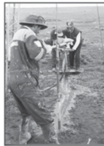
Lubricación de la perforación con bentonita
