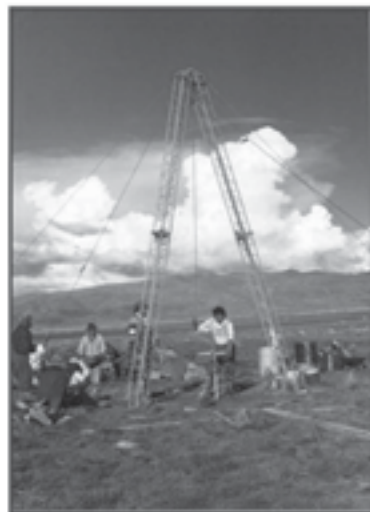
Perforación manual por percusión – rotación
