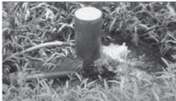
Ariete en la fase de alivio a través de la válvula de cheque
