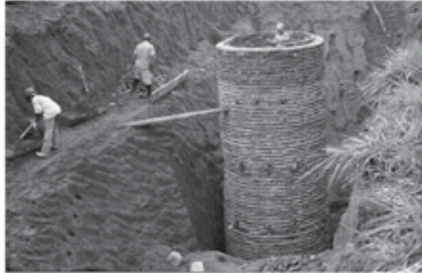
Pozo de inspección en la construcción de un alcantarillado en Arauca
