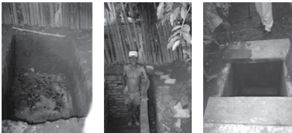
Construcción tanque interceptor
